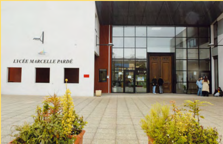
Verre, aluminium et porte d'époque : la rénovation réussie d'un lycée professionnel.
